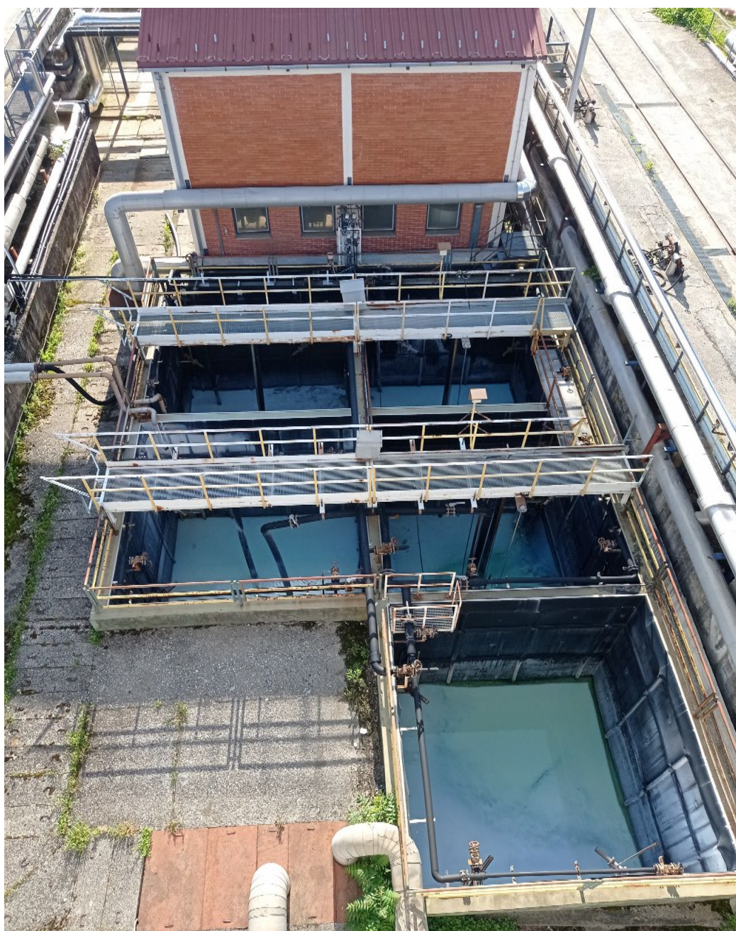
Slika 5. Neutralizacijski bazeni [9]
