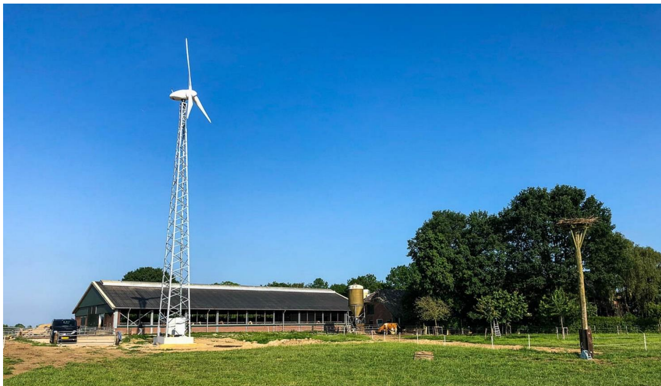
Slika 16: Predodžba vjetroturbine RyseEnergy 20kW turbina na farmi u Nizozemskoj
