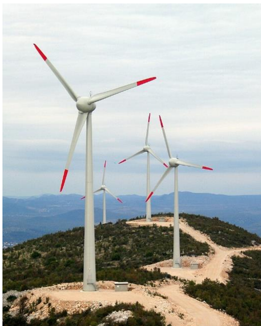
Slika 5: Predodžba vjetroturbine s horizontalnom osi vratila
