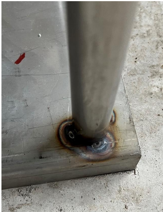
Slika 32: Predodžba spojeva cijevi na postolju i na gornjem učvršćenju. Izvorno autor.
