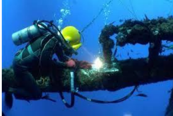
Sl. 46. Zavarivač u ronilačkom odijelu s opremom [35]
