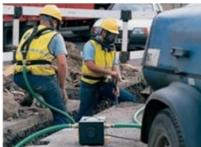
Sl. 11. Cijevni uređaj s dovodom čistog zraka pomoću puhala [13]
