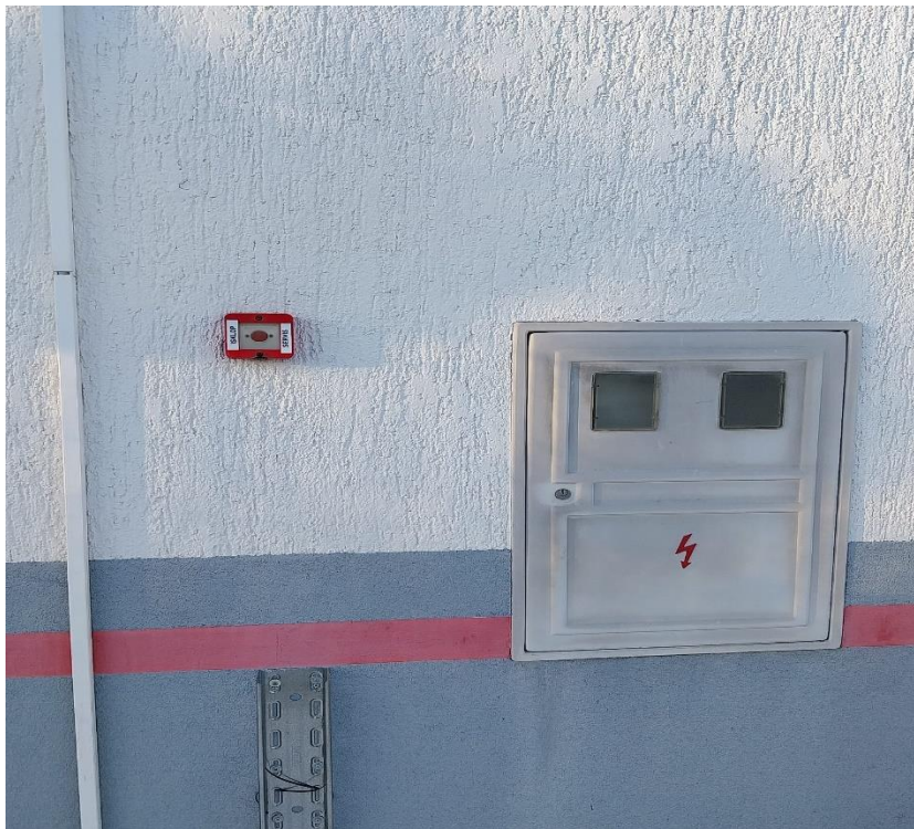
Slika 11. Tipkalo za isklup električne energije [16]
