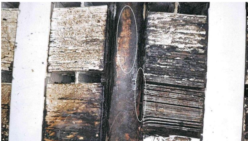
Slika 14: Oštećenja grafitnog laka u rasklinjenom utoru
