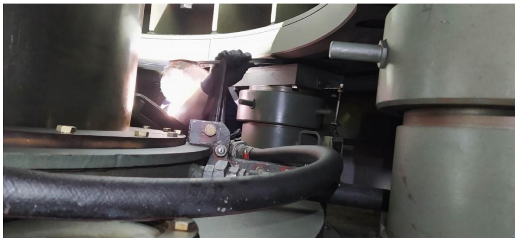
Slika 10: Mjerenje zračnosti pomoću instrumentalnog lima
