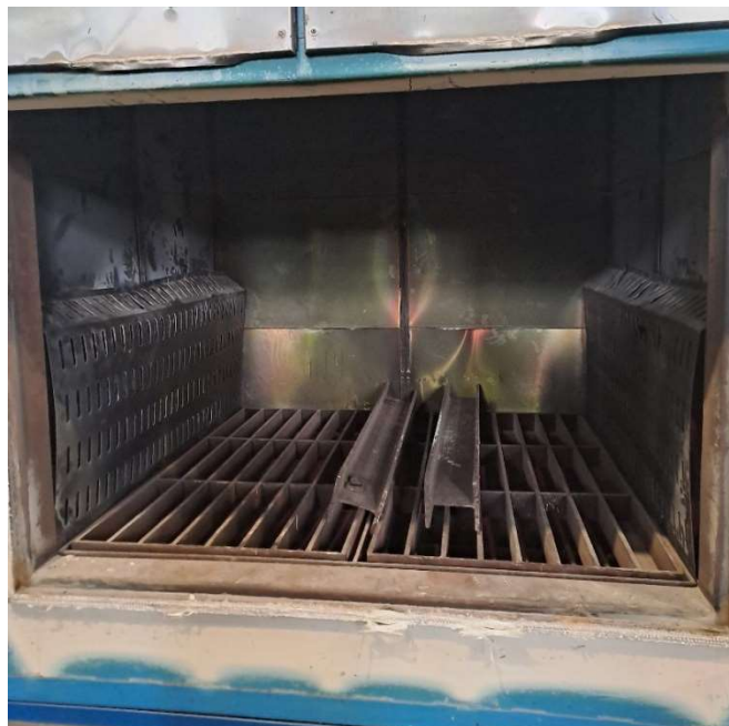
Slika 3. Unutrašnjost električne peći (izvorno autor)
