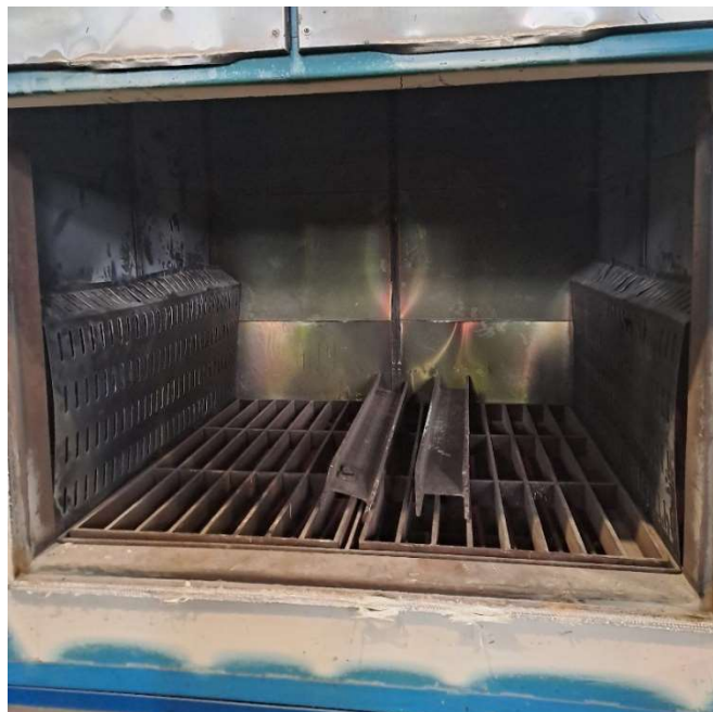
Slika 3. Unutrašnjost električne peći (izvorno autor)
