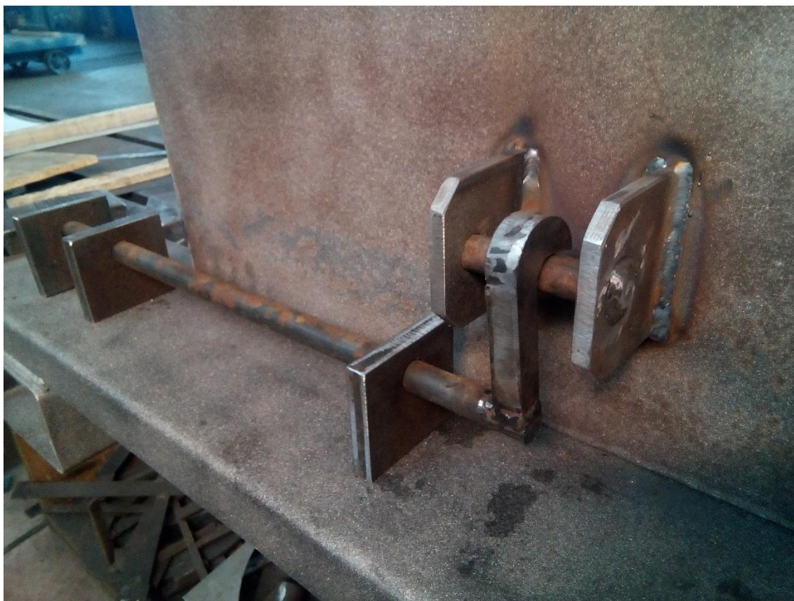
Slika 47. Zavarivanje mehanizma otključavanja, brave i nosača mehanizma
