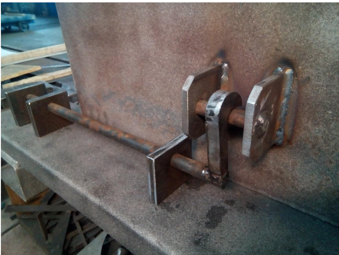
Slika 47. Zavarivanje mehanizma otključavanja, brave i nosača mehanizma
