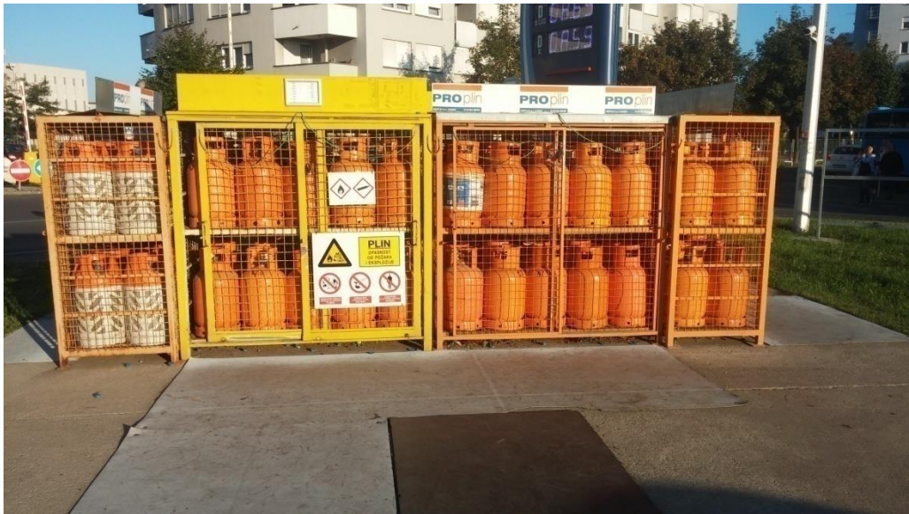
Slika 14. Spremište plinskih boca
