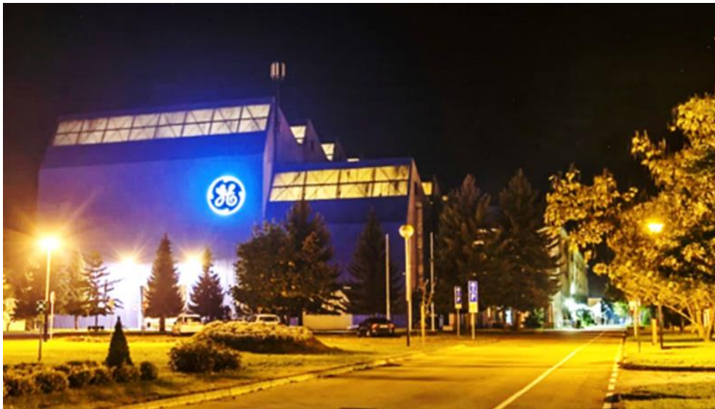
SLIKA 6. Pogon General Electric Hrvatska d.o.o., Mala Švarča 197, 47000 Karlovac
