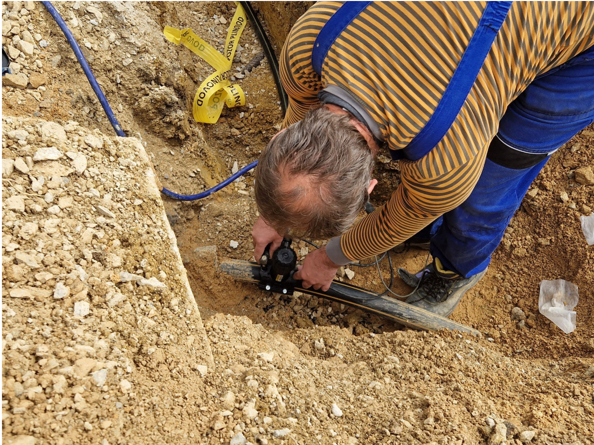
Slika 37. Montiranje kabela na pinove sedla [Izvorno autor]
