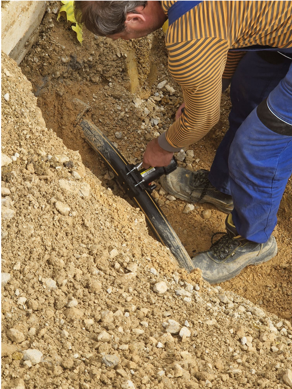
Slika 34. Montiranje sedla [Izvorno autor]
