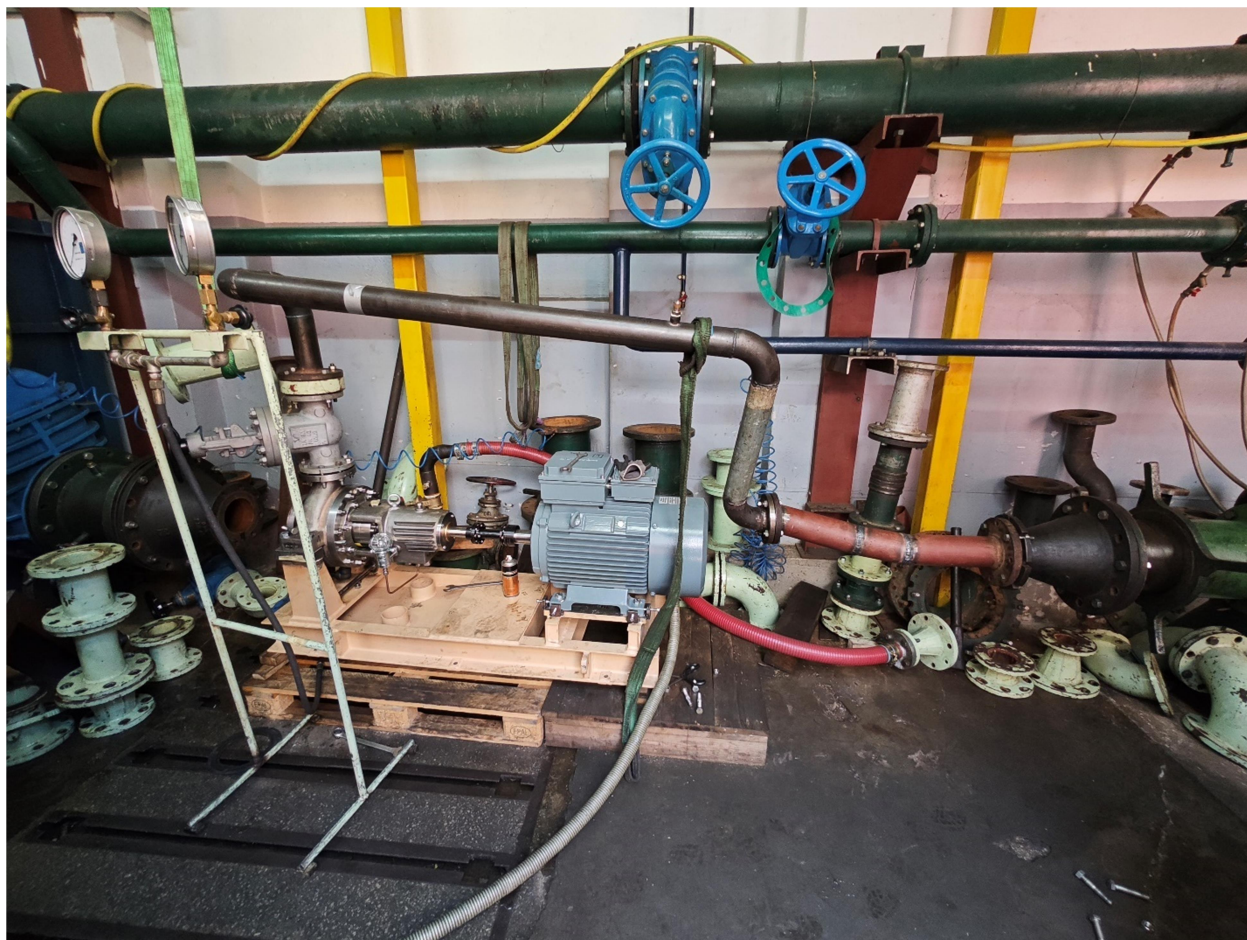
Slika 35 Postav pumpe na cjevovod
