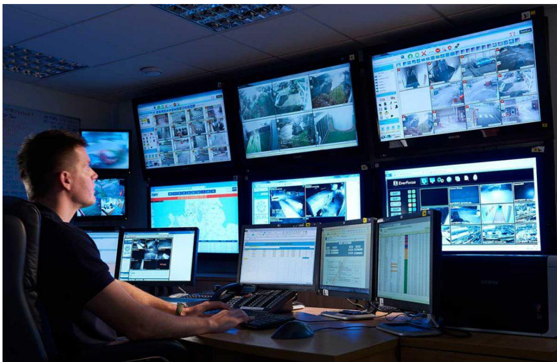
Slika 3.2. Prikaz kontrolne sobe, centralni dojavni sustav [4]
