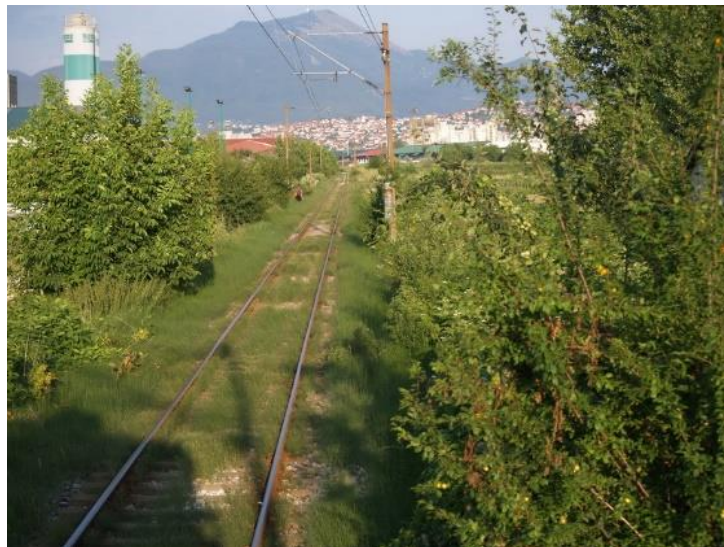
Slika 36: Primjer Ugroženosti željezničke kontaktne mreže od visokih stabala
