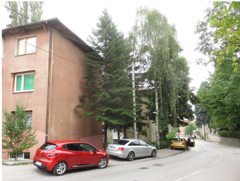
Slika 34: Ugroženost telekomunikacijske i električne mreže od strane visokog drveća
