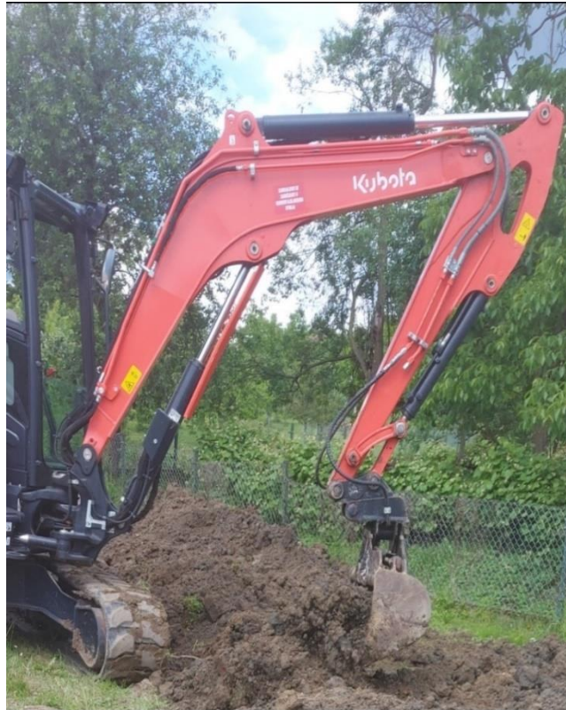
Slika 27. Zatrpavanje kanala pomoću mini bagera
