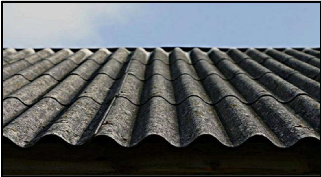
Slika 2 - Primjer azbesta, azbestni krovni pokrov [14].
