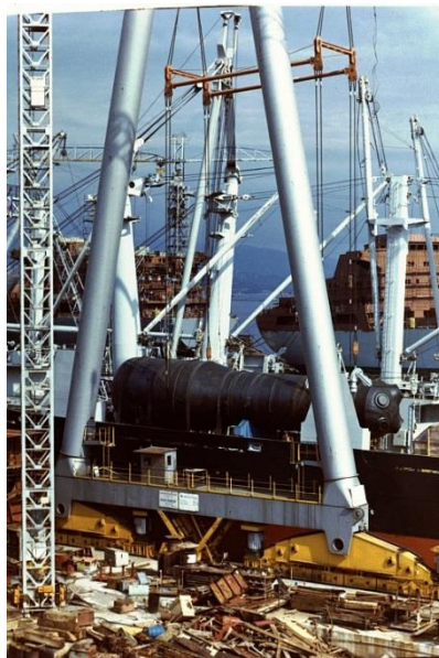
Slika 5 Oprema za nuklearni dio elektrane[11]
