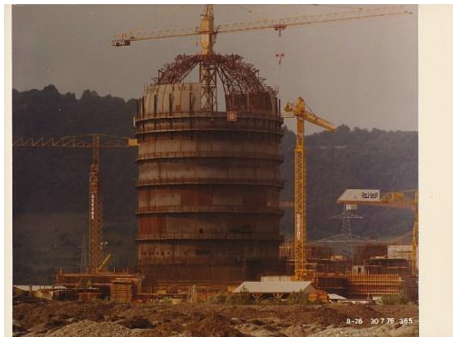
Slika 6 Montaža reaktorskog dijela[11]
