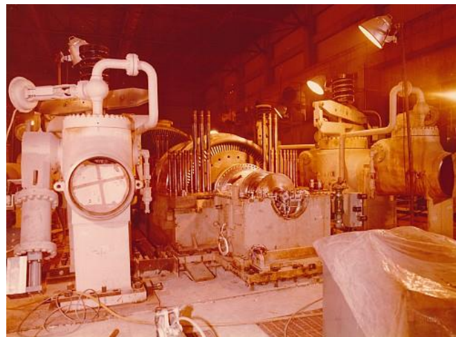
Slika 7 Montaža turboagregata[11]
