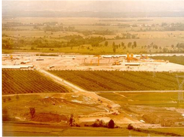
Slika 4 Početak građevinskih radova[11]
