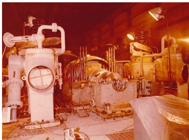
Slika 7 Montaža turboagregata[11]
