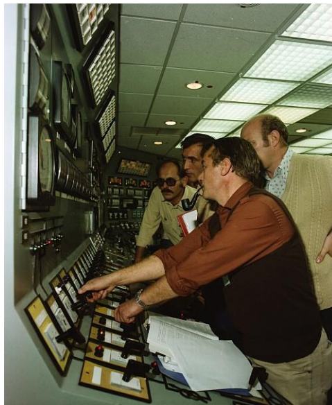
Slika 11 Sinkroniziranje generatora s mrežom[11]
