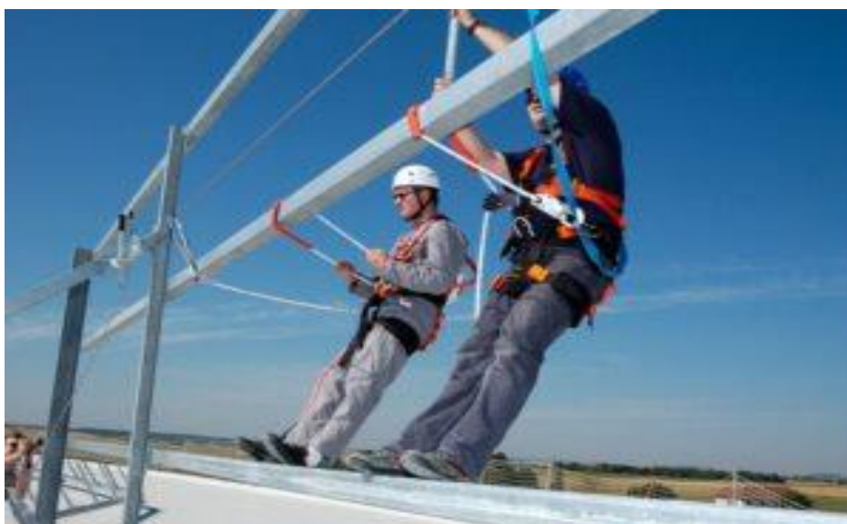
Slika 1. Pravilno korištenje zaštitne opreme pri radu na visini
