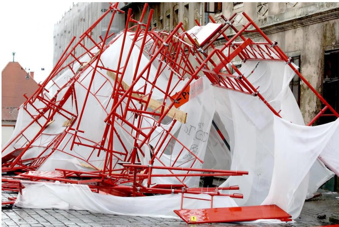
Slika 3. Opasna sinergija između vjetra i skele
