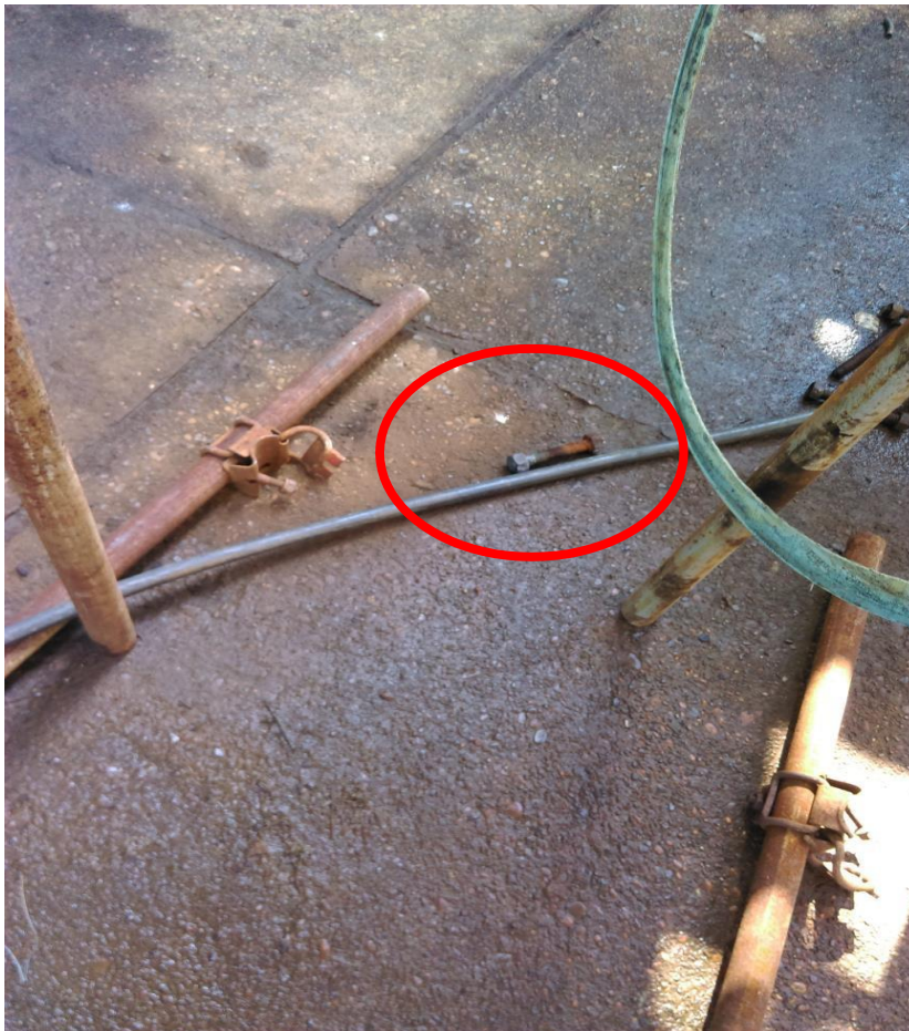
Slika 6. Padovi strojnih elemenata i alata sa skele
