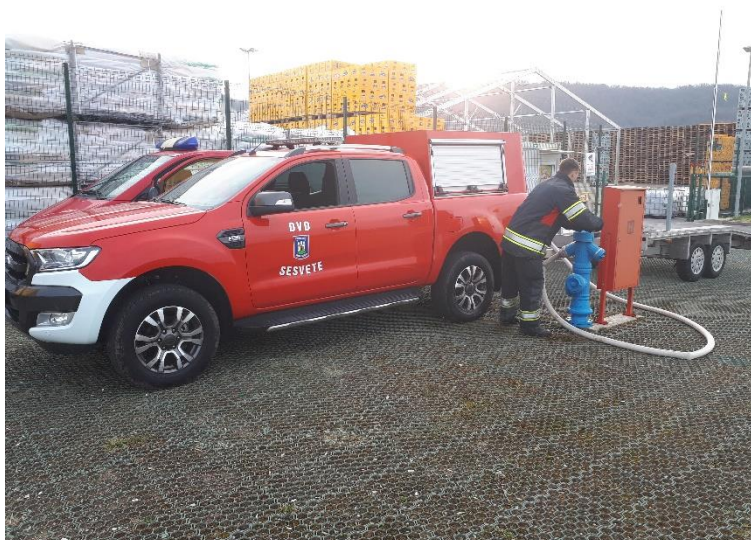
Slika 19. Priključivanje tlačnog crijeva na nadzemni hidrant [10]
