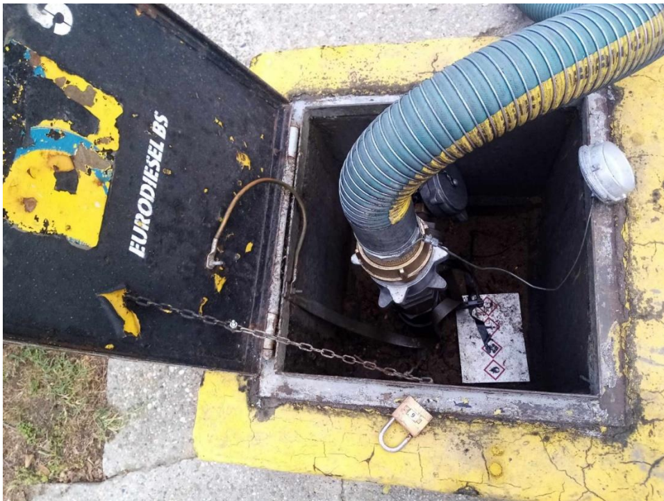
Slika 9. Šaht za istakanje goriva (oko spremnika)
