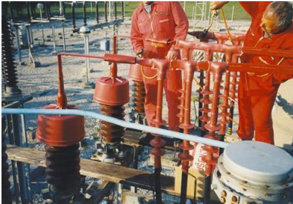
Slika 24: Prikaz izrade izoliranog elektroenergetskog postrojenja
