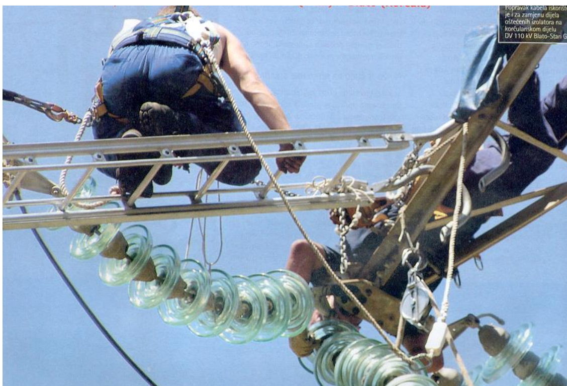
Slika 21: Prikaz zamjene izolatorskog lanca na dalekovodnom stupu
