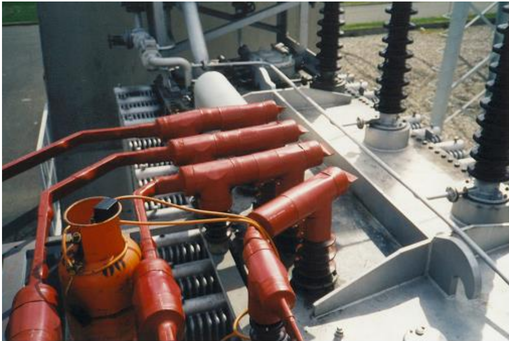
Slika 7: Izoliranje transformatorskih sabirnica
