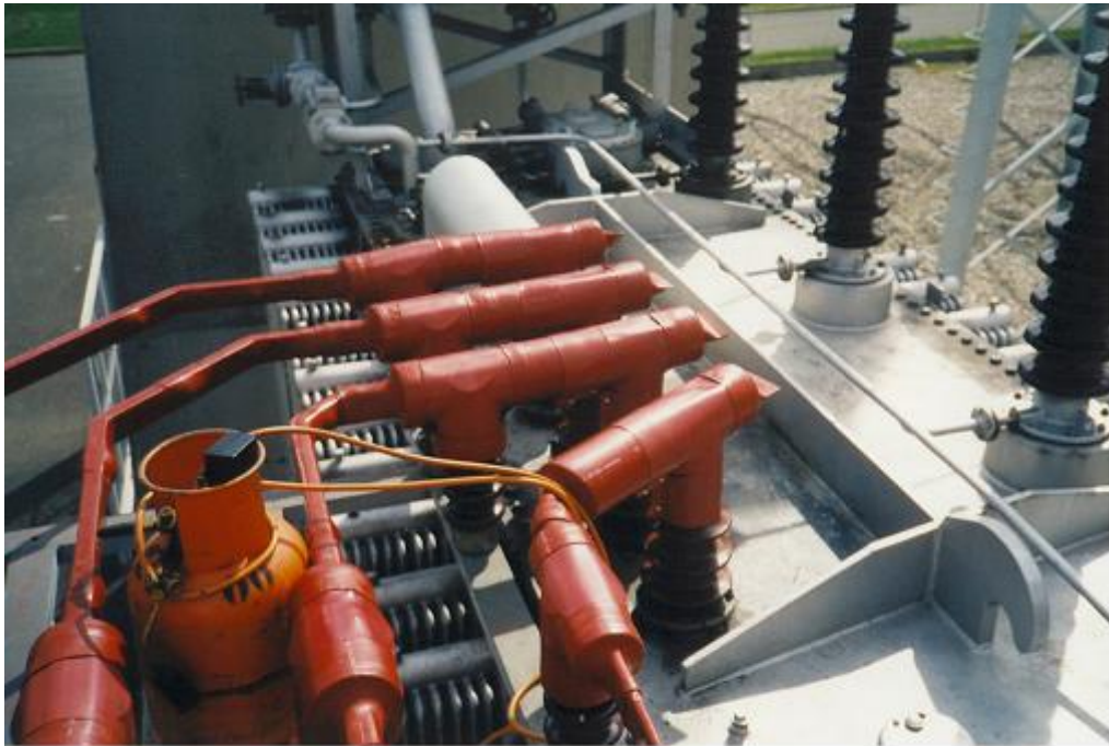
Slika 7: Izoliranje transformatorskih sabirnica
