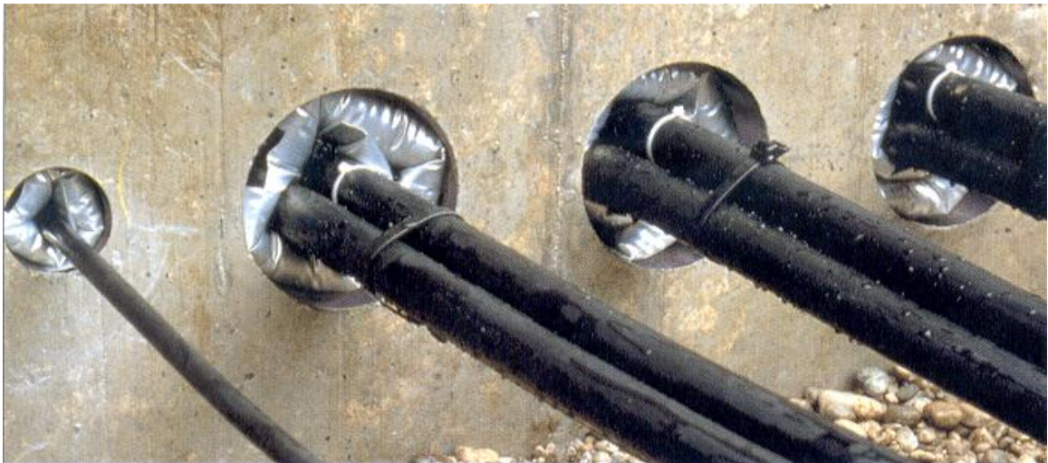
Slika 25: Prikaz zaštite prolaza kroz uvedne kanale trafostanice
