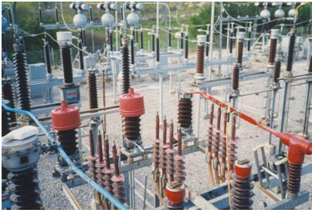
Slika 5: Rasklopno postrojenje u fazi izrade izolacije
