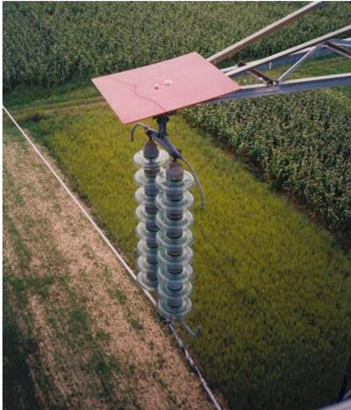
Slika 23: Prikaz zaštite izolatorskog lanca od životinja
