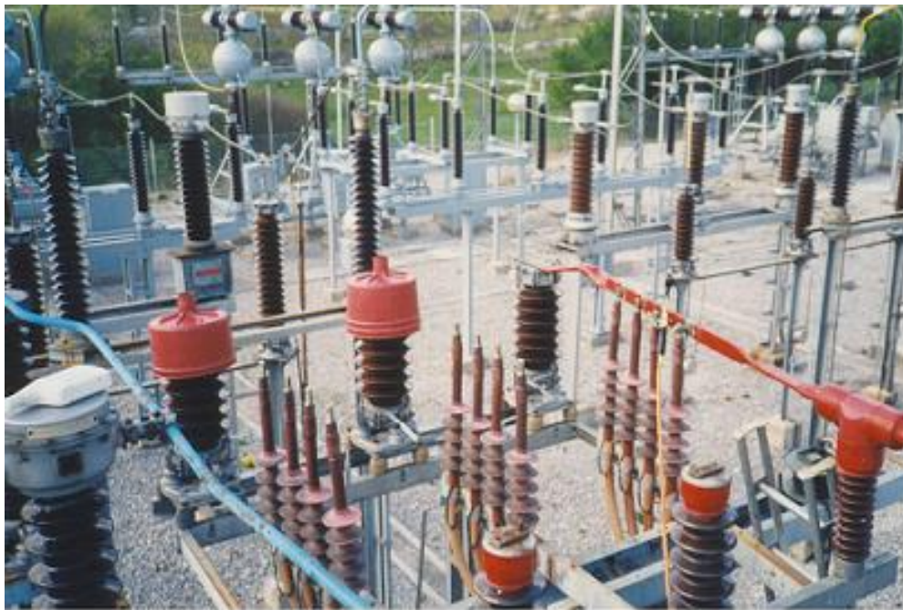
Slika 5: Rasklopno postrojenje u fazi izrade izolacije
