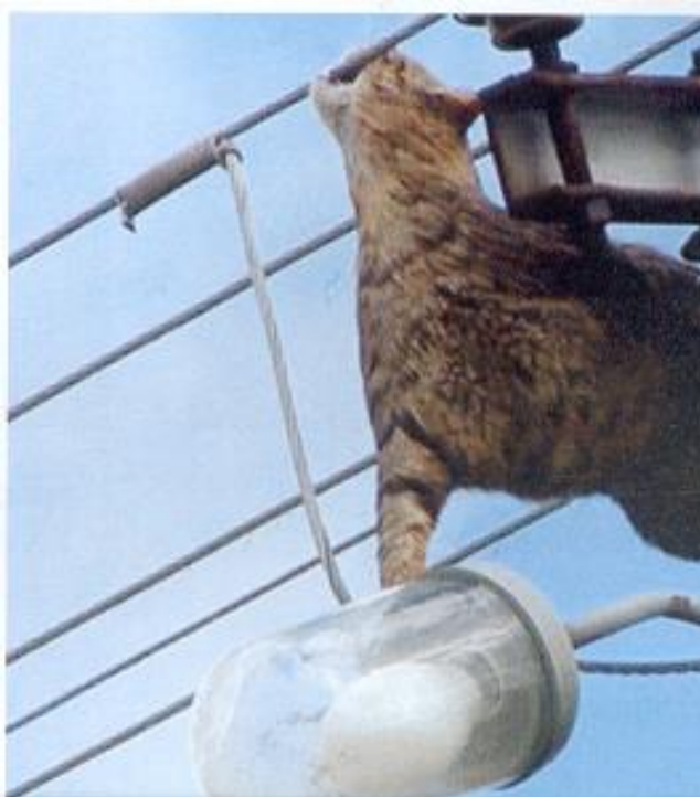
Slika 15: Prikaz dozemnog spoja izazvan mačkom
