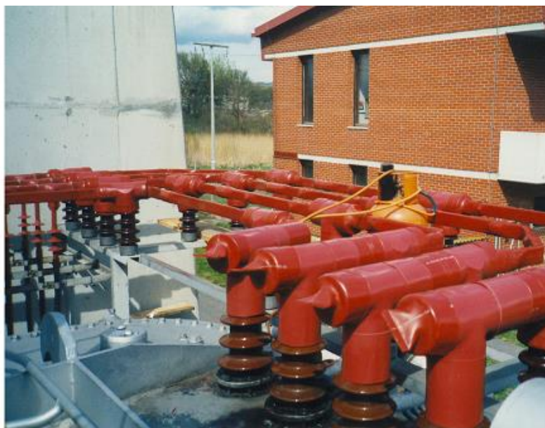
Slika 8: Izolirane transformatorske sabirnice
