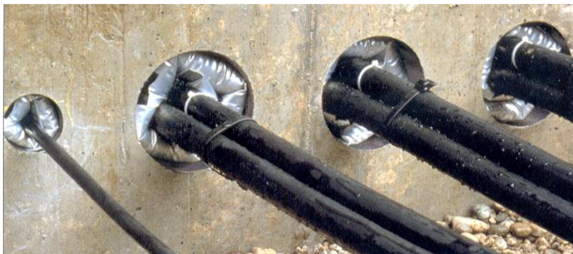
Slika 25: Prikaz zaštite prolaza kroz uvedne kanale trafostanice
