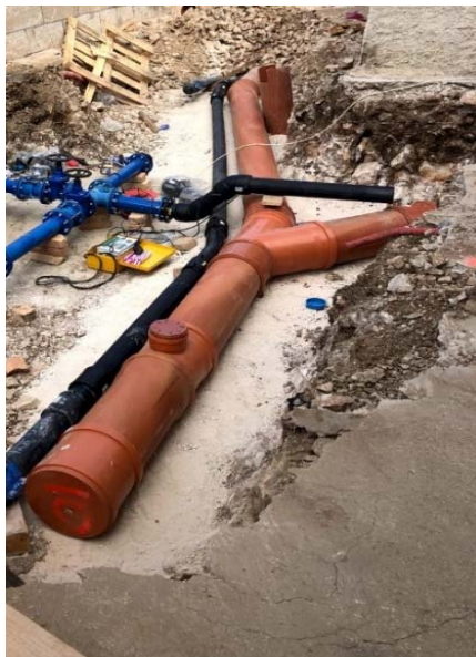
Slika 38: Cijev za uličnu kanalizaciju SN4 315x6000 mm [33]
