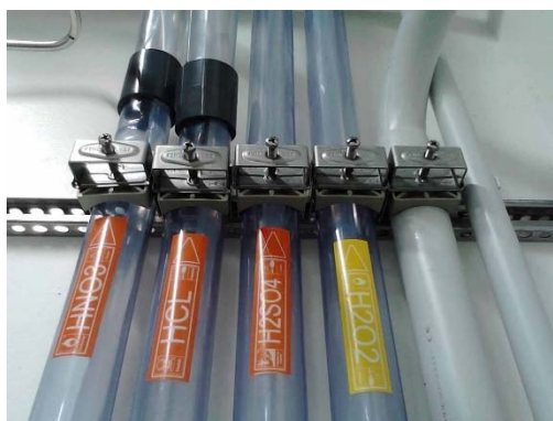
Slika 20: PVC cijevi za transport kiselina [24]
