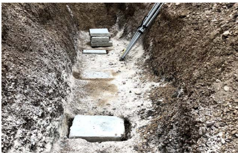
Slika 37: Iskopan rov sa sidrenim (betonskim) blokovima [33]
