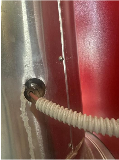
Slika. 11 Montiran senzor temperature Izvor: Autor
