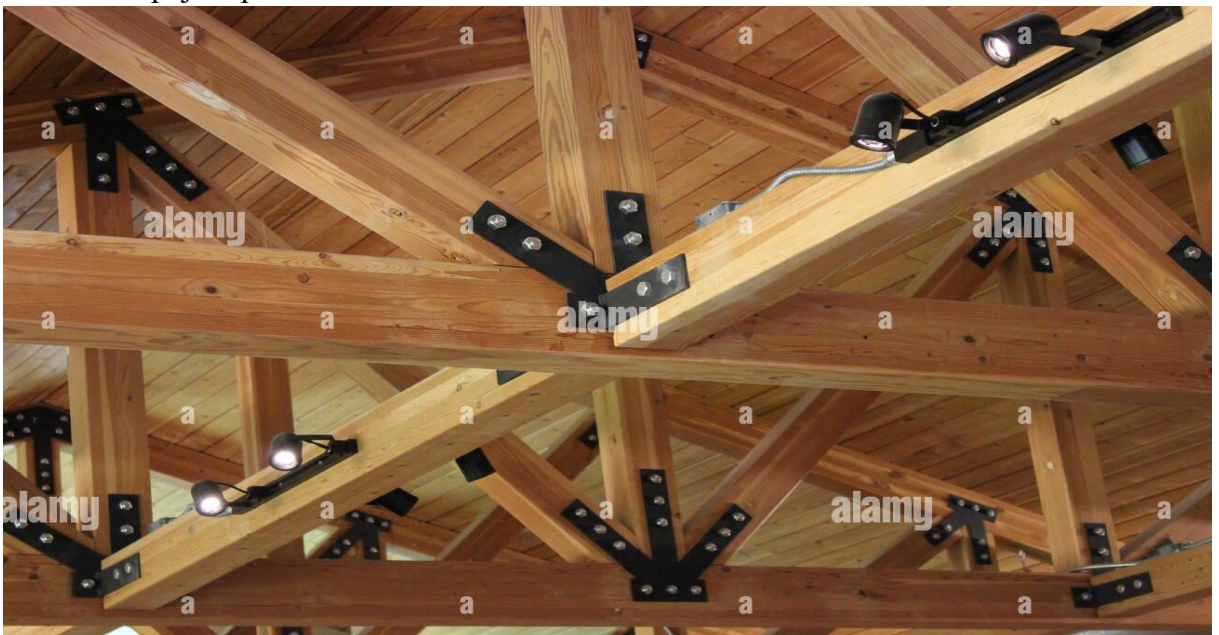
Slika 6. Moderna konstrukcija krova s elementima strojarstva [19]
