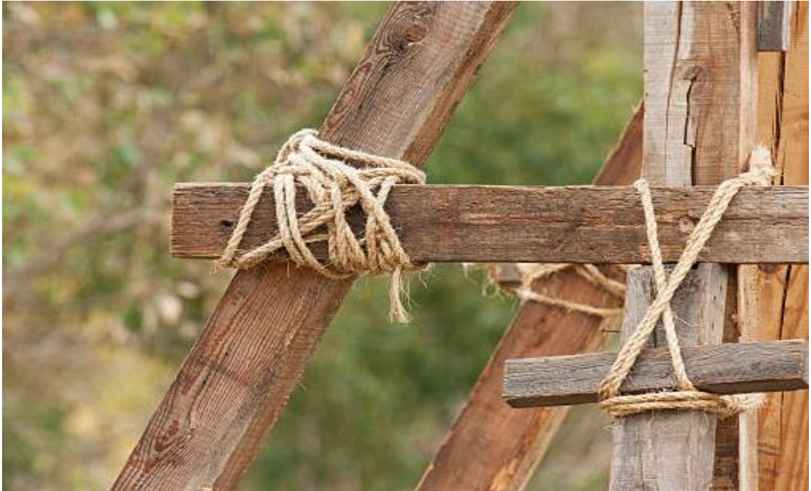
Slika 4. Primitivni spoj užetom [3]
