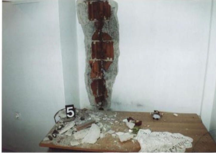
Slika 15. Podžbukno preopterećenje strujnog kabela [24]
