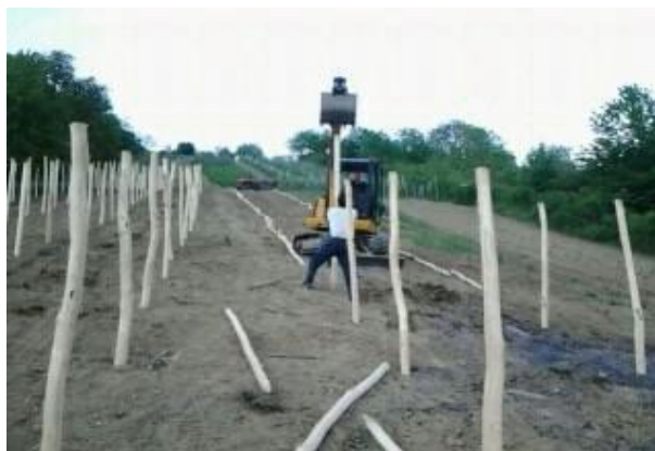
Slika 3 Prikaz postavljanja stupova od agacije (vlastita fotografija)
