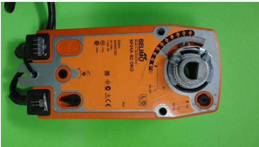
Slika 2. Rotacijski aktuator [11]
