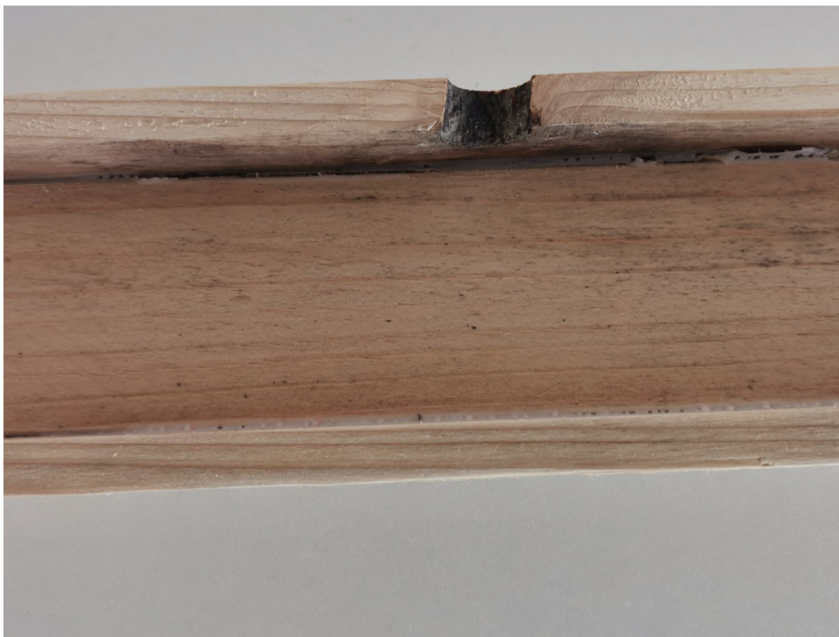
Slika 55. Prikaz odstranjenog trulog dijela ,vlažnost, te smjer i raspored vlakana nosača 1
