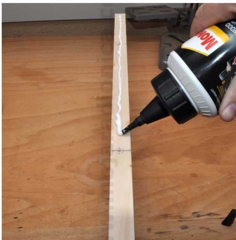
Slika 31. Nanošenje ljepila na priključni drveni element. [67]
