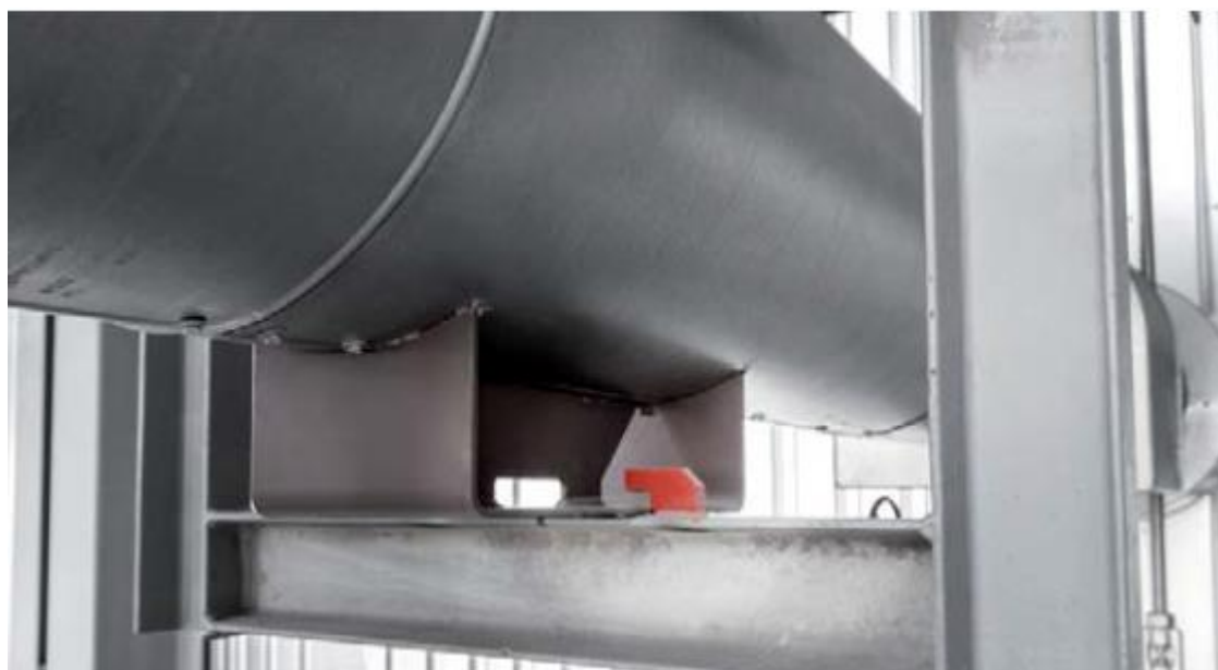
Slika 26: Podupirač cijevi[12]
