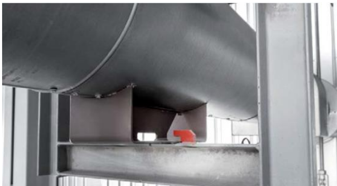
Slika 26: Podupirač cijevi[12]
