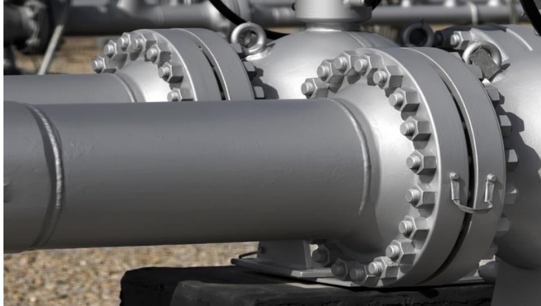
Slika 9: Način spajanja prirubnicom[9]
