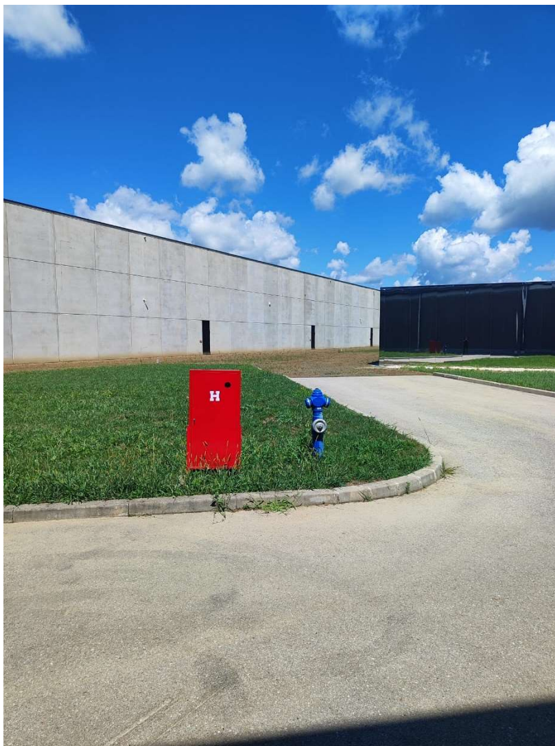
Slika 14: Vanjski hidranti
