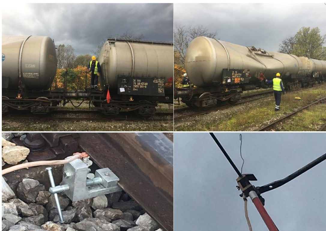
Slika 15 .Uzemljenje željezničkih vagona
