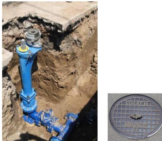
Slika 40. Podzemni hidrant [18]
