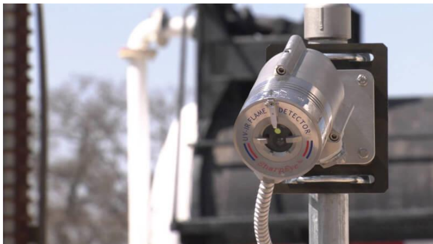
Slika 14. Javljač požara sa ultraljubičastim i infracrvenim senzorom [6]
