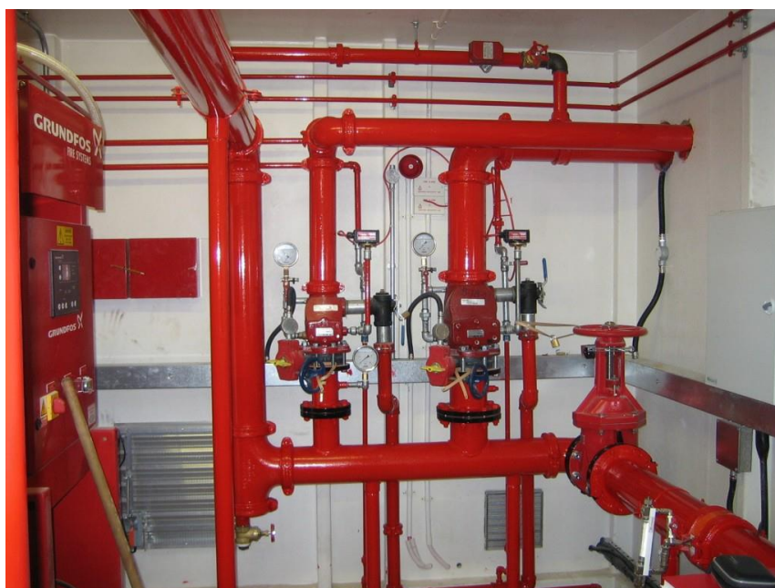
Slika 33. Drencher sustav sa deluge ventilom [16]
