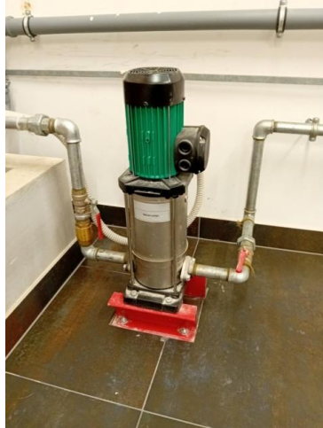
Slika 48. Pumpa za održavanje tlaka u sustavu [21]
