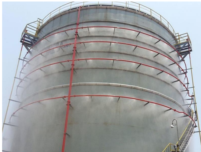
Slika 34. Prikaz zaštite pomoću drencher stabilnog sustava [16]
