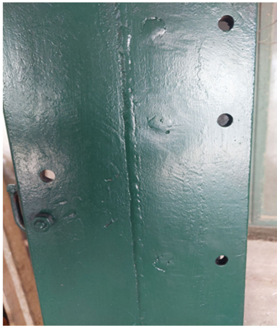
Slika 42. Zavar i glavna konstrukcija prefarbana antikorozivnom bojom
