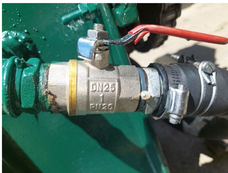
Slika 27. Hidraulički protočni ventil
