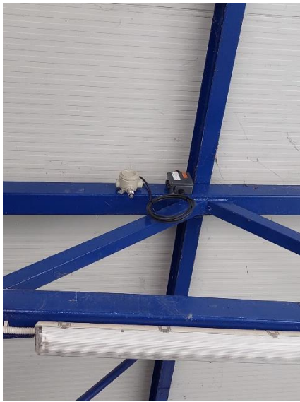
Slika 19: a) Senzor za CH 4 ; b) Senzor za H 2 S (autorske slike)
