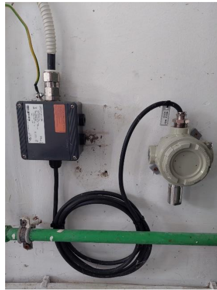
Slika 19: a) Senzor za CH 4 ; b) Senzor za H 2 S (autorske slike)
