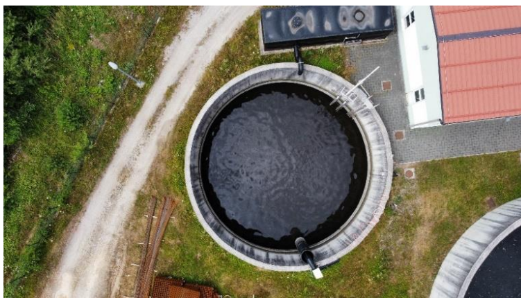
Slika 8: Izlazni egalizacijski međuspremnik (autorske slike)
