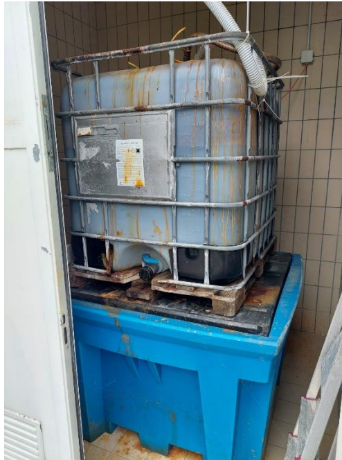
Slika 15: Spremnik s \text{FeCl}_3 i tankvana (autorske slike)
