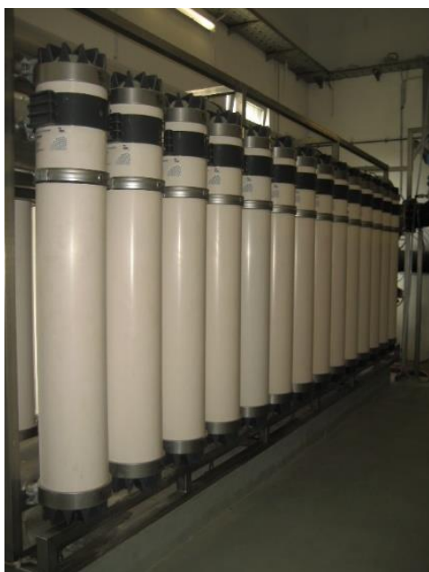
Slika 9: a) Ultrafiltracijski sustav; b) Membrane (autorske slike)
