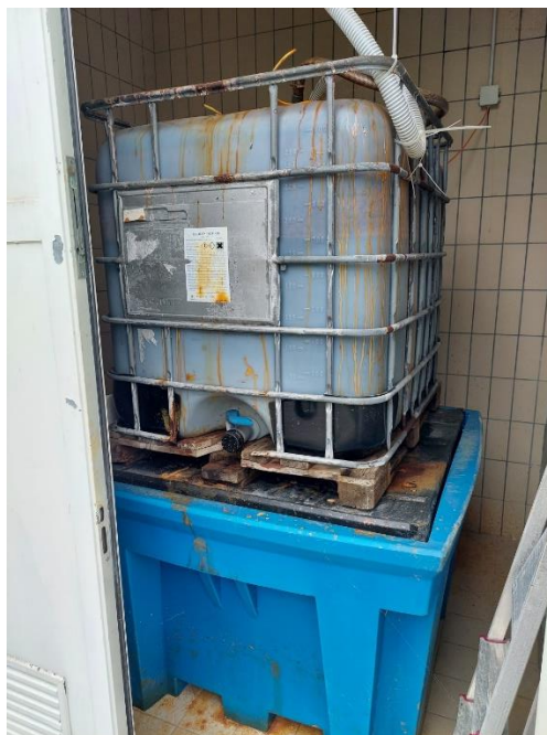
Slika 15: Spremnik s \text{FeCl}_3 i tankvana (autorske slike)
