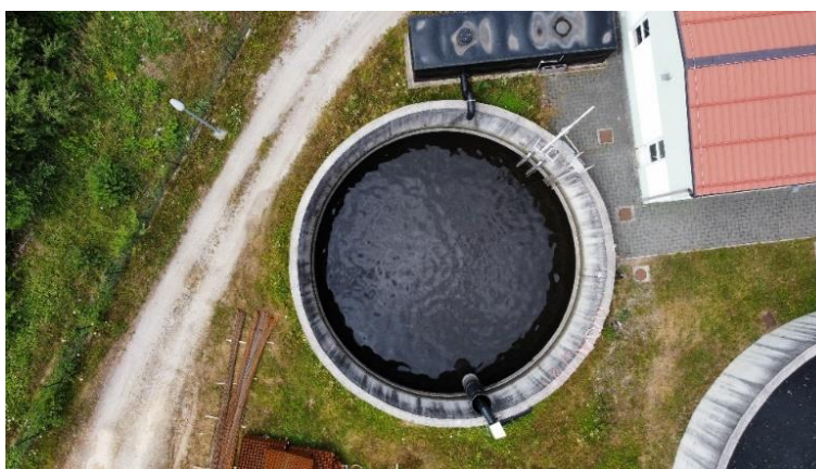
Slika 8: Izlazni egalizacijski međuspremnik (autorske slike)
