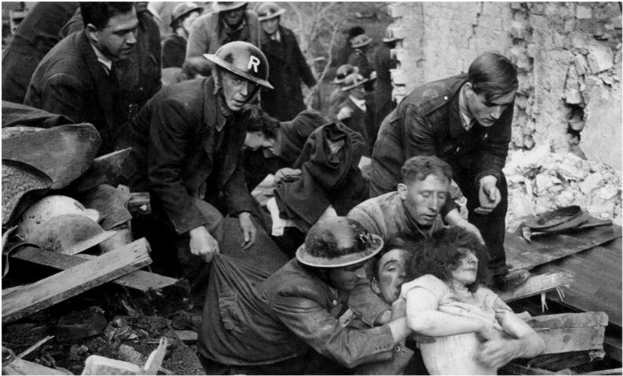
Slika 17. Odjel za spašavanje civilne zaštite
