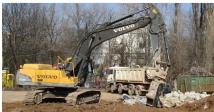
Slika 6. Oprema za rušenje na licu mjesta [12]
