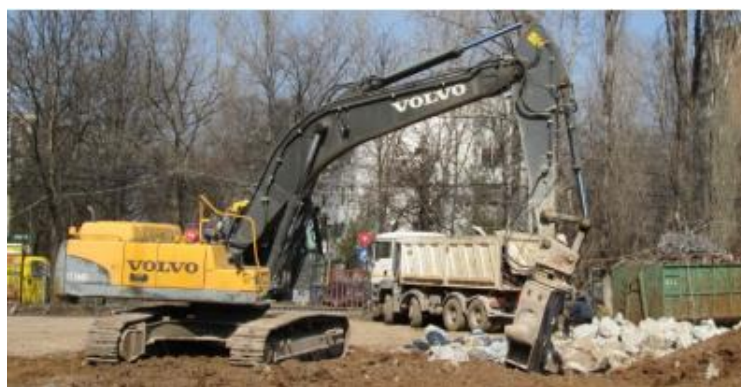
Slika 6. Oprema za rušenje na licu mjesta [12]
