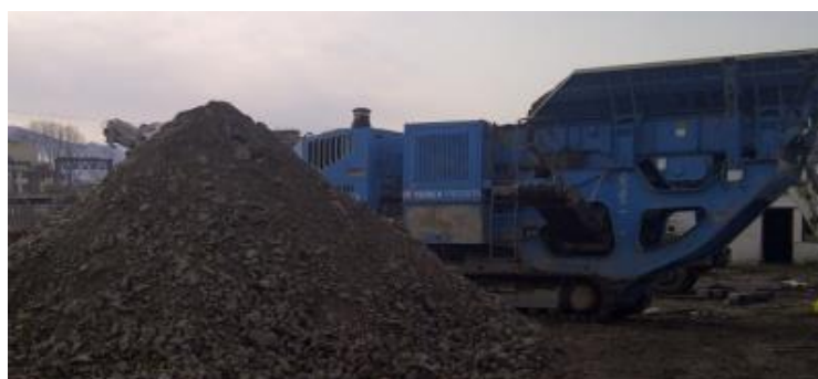
Slika 7. Drobljenje konstrukcijskog betona na licu mjesta [12]
