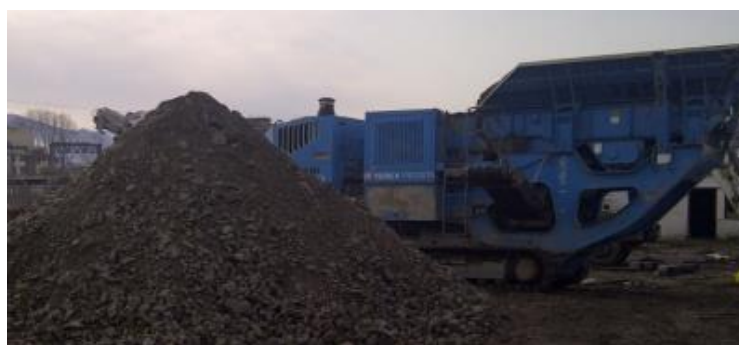
Slika 7. Drobljenje konstrukcijskog betona na licu mjesta [12]
