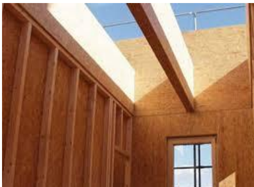
Slika 36. Izrada kuće od kompozitnih ploča [2]
