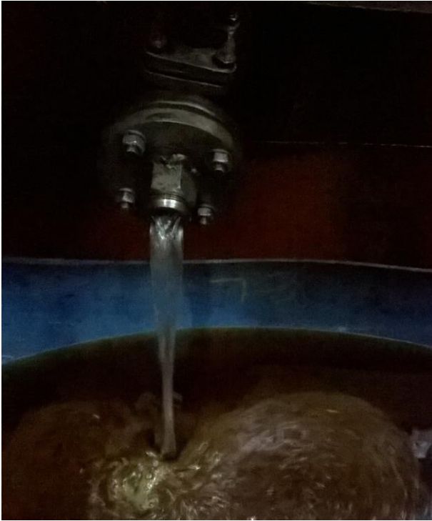
Slika 32. Dreniranje slobodne vode
