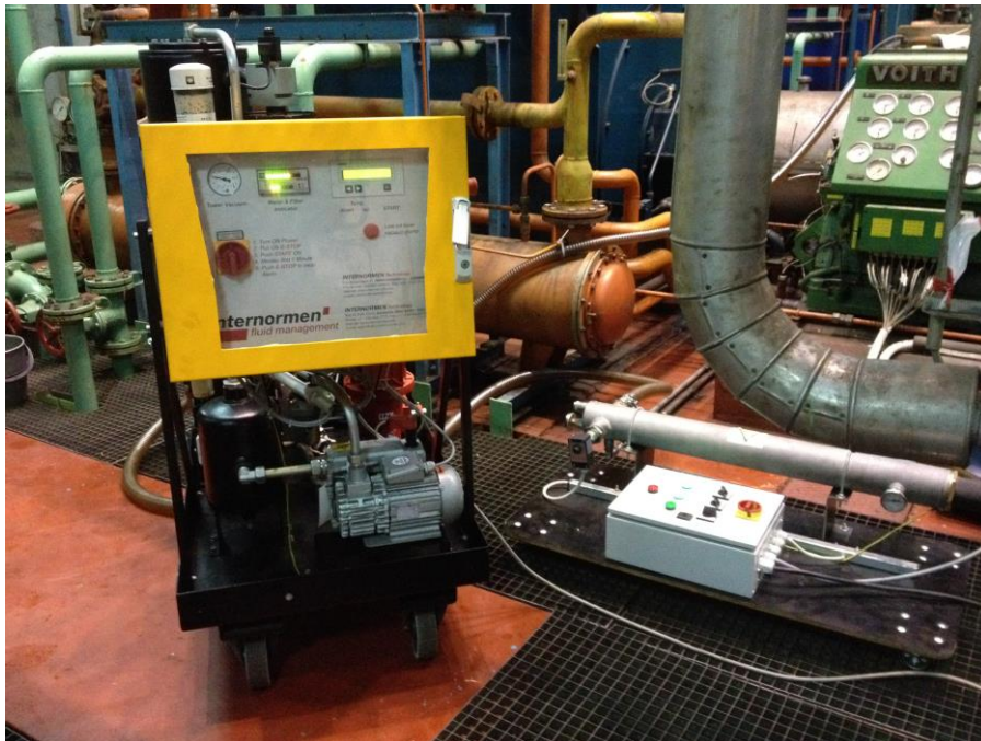
Slika 34. IFPM 21 i grijač ulja spremni za puštanje u rad
