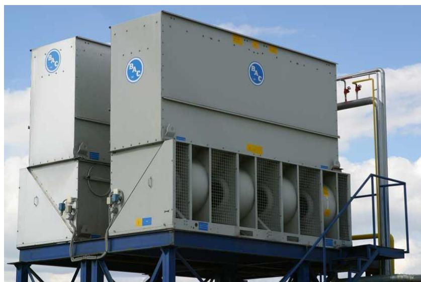
Slika 12. Evaporativni kondenzator
