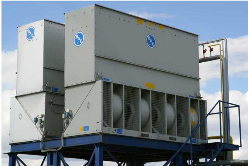
Slika 12. Evaporativni kondenzator
