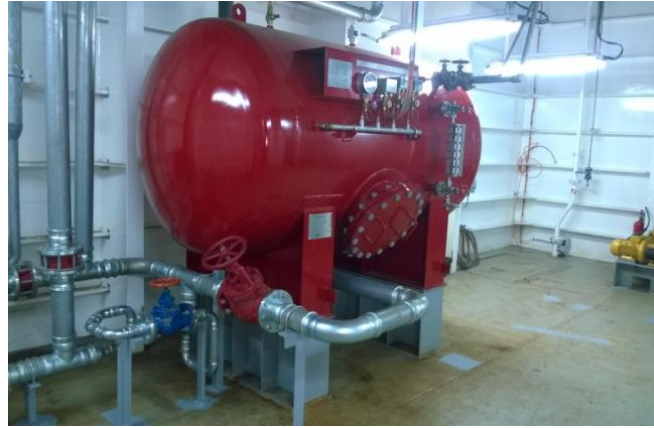
Slika 32. Predodžba tlačnog spremnika za sprinkler sustav
