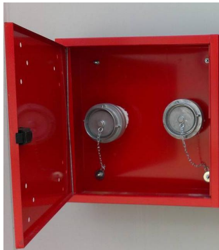
Slika 33. Predodžba priključka sprinkler sustava na vatrogasno vozilo
