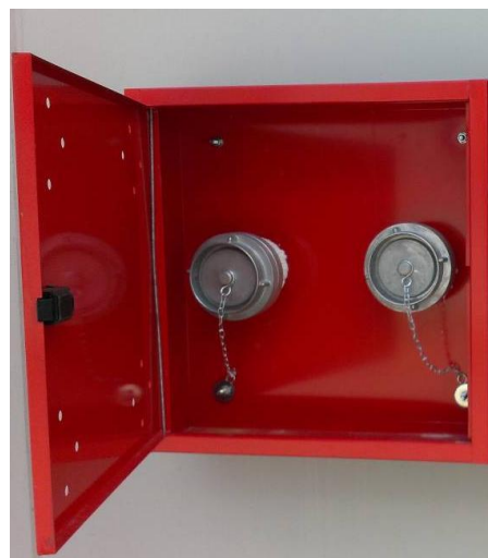
Slika 33. Predodžba priključka sprinkler sustava na vatrogasno vozilo
