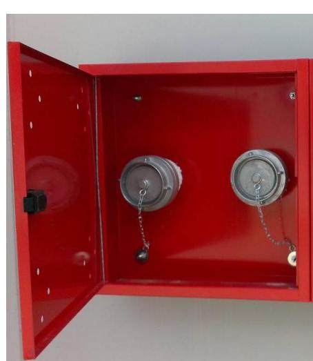
Slika 33. Predodžba priključka sprinkler sustava na vatrogasno vozilo
