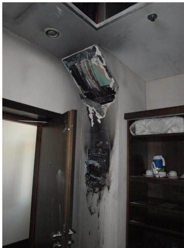
Slika 14. Predodžba požara ugašenog jednom sprinkler mlaznicom
