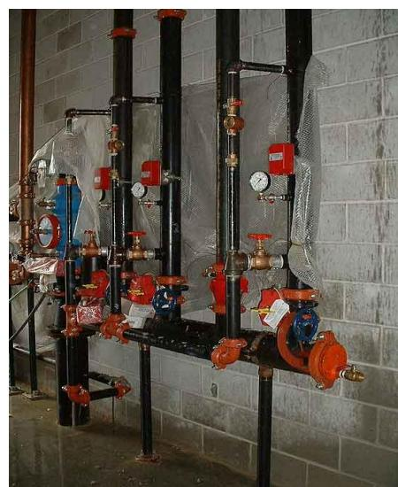
Slika 31. Predodžba direktnog priključka sprinkler sustava na gradski cjevovod
