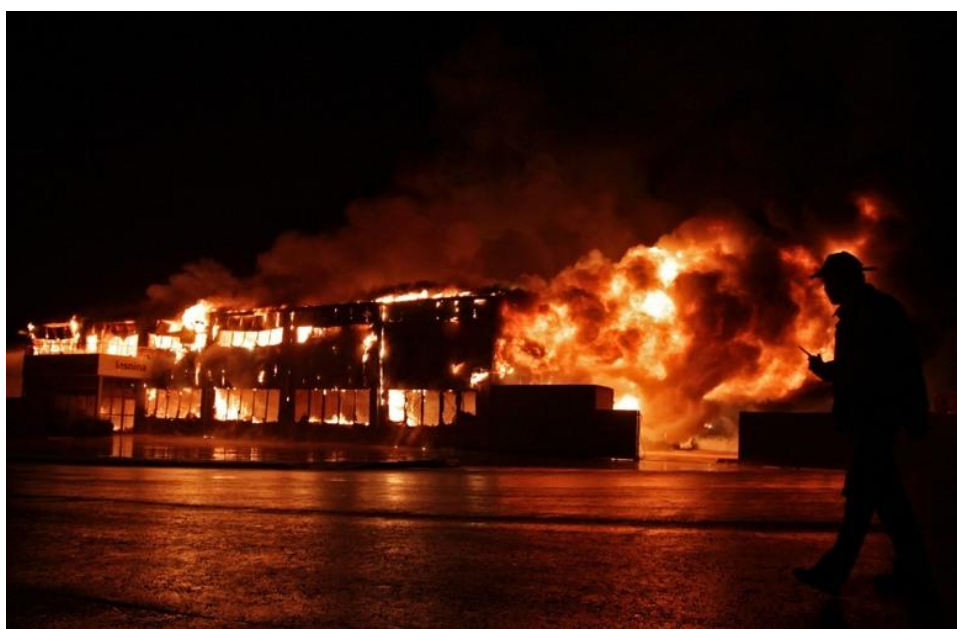
Slika 13. Predodžba skladišta Lesnina u požaru
