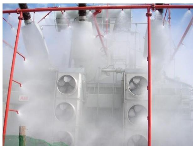
Slika 18. Predodžba Drencher sustava za zaštitu postrojenja
