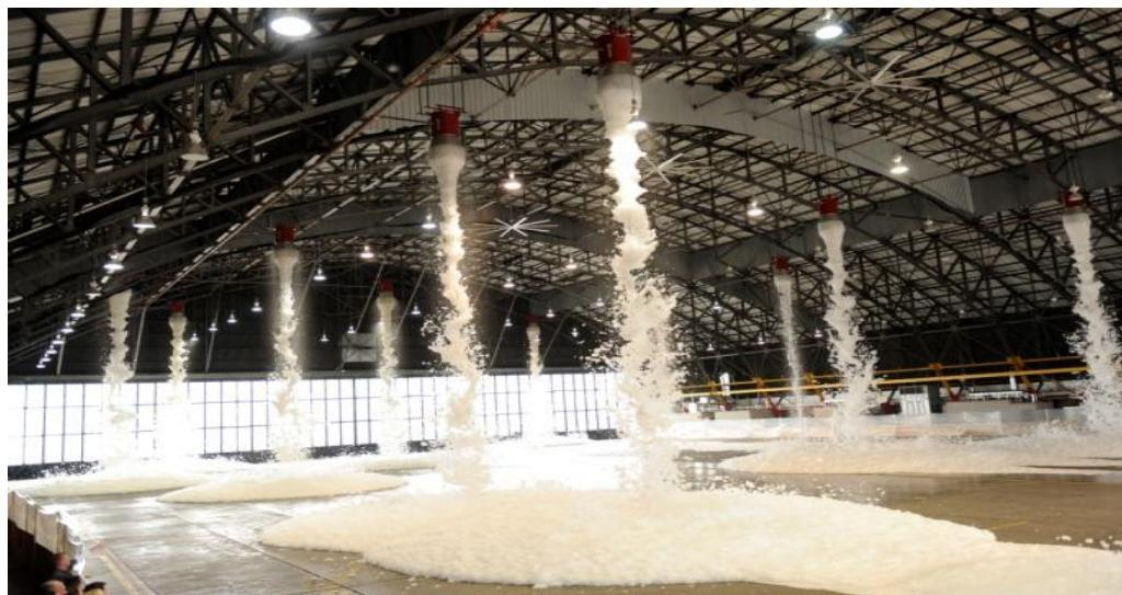
Slika 24. Predodžba sustava za gašenje pjenom u hangaru za avione
