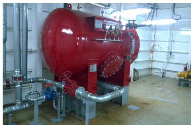
Slika 32. Predodžba tlačnog spremnika za sprinkler sustav
