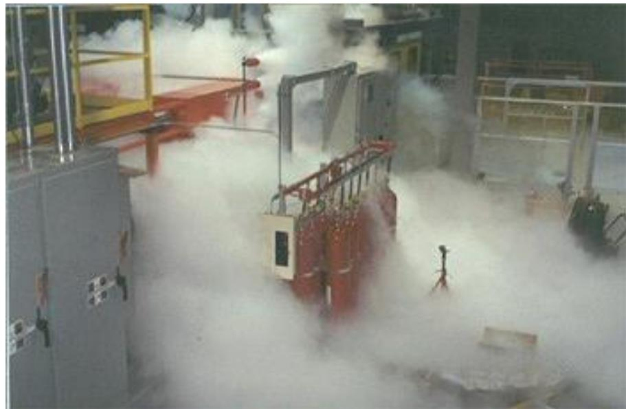
Slika 22. Predodžba gašenja postrojenja plinskim sustavom za gašenje ugljikovim dioksidom
