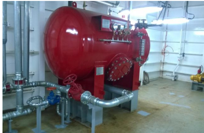
Slika 32. Predodžba tlačnog spremnika za sprinkler sustav
